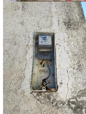
7. Le boîtier sur le poteau électrique qui gère l'éclairage des rues est endommagé. Son couvercle en acier de plusieurs kg ne tient qu'avec une petite ficelle facilement détachable par un enfant curieux et vandalisant. Ce qui représente un danger de mort ou de blessure si le couvercle tombe
